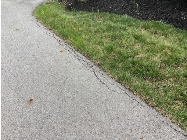
Edge cracks
